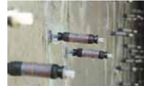
注入材の養生
